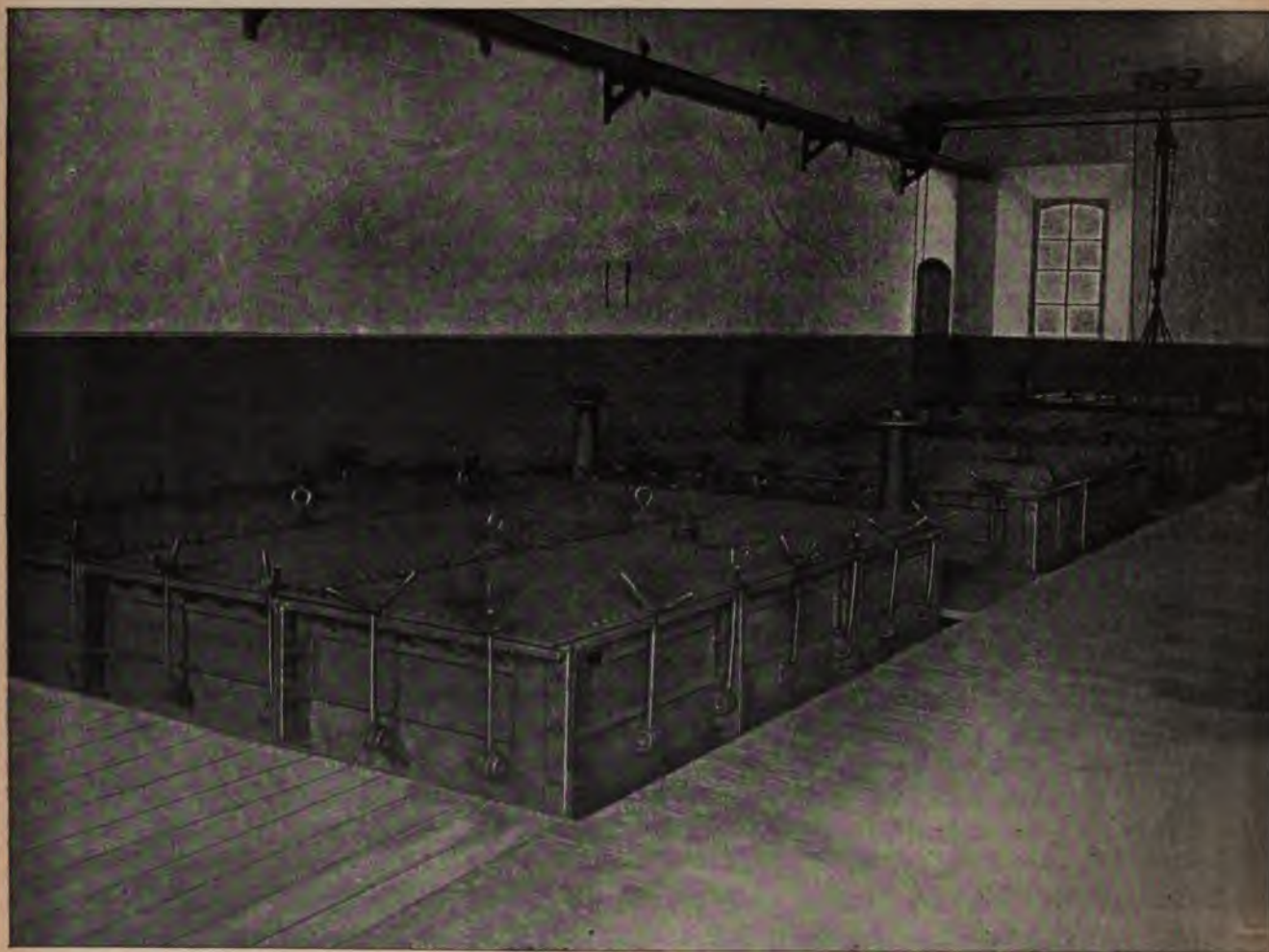
Fig. 5 — Sala della depurazione
